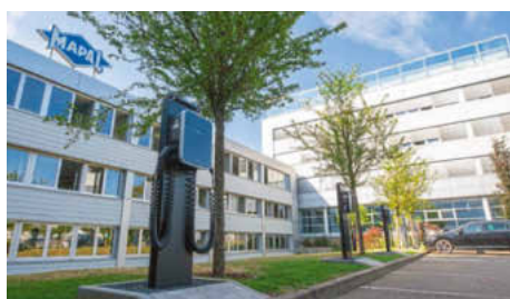
Auf dem Parkplatz im Werk Aalen sind bereits sechs E-Ladesäulen installiert. Die Lademöglichkeit steht Besucher- und Firmenfahrzeugen zur Verfügung.
