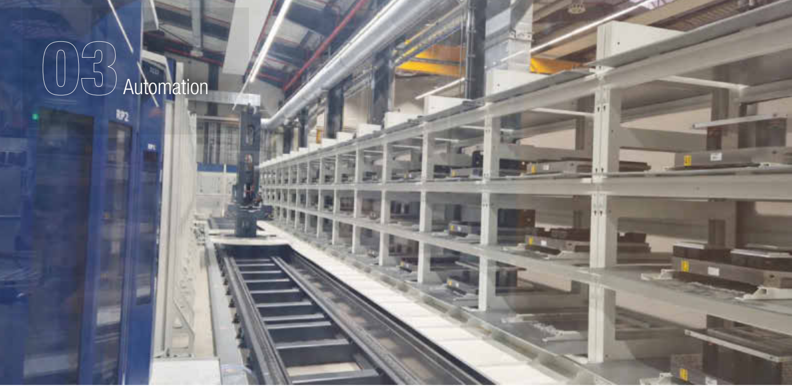
Das PHS 1500 Allround von Liebherr bei der GEA Group am Standort Wallau. Bild: Liebherr
